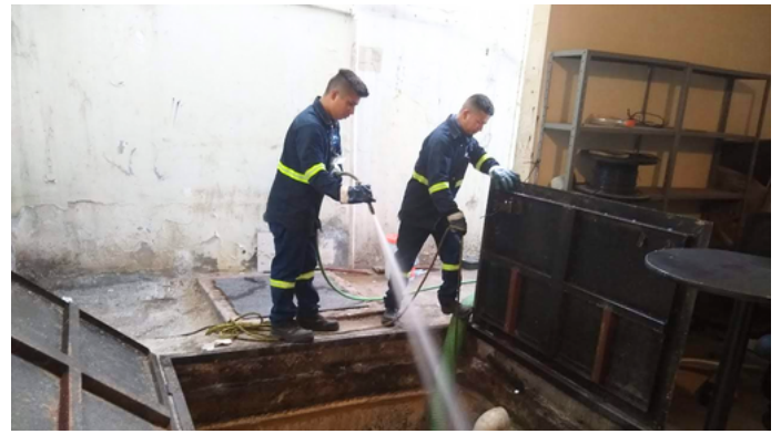
LIMPIEZA DE TRAMPAS DE GRASA
